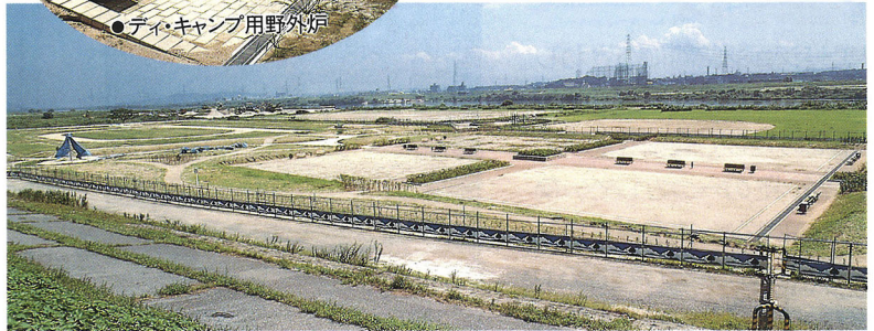
●大塚地区・新施設全景
