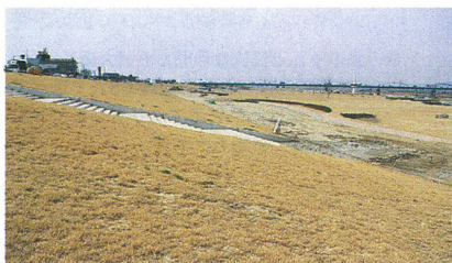
傾斜のゆるい堤防法面
